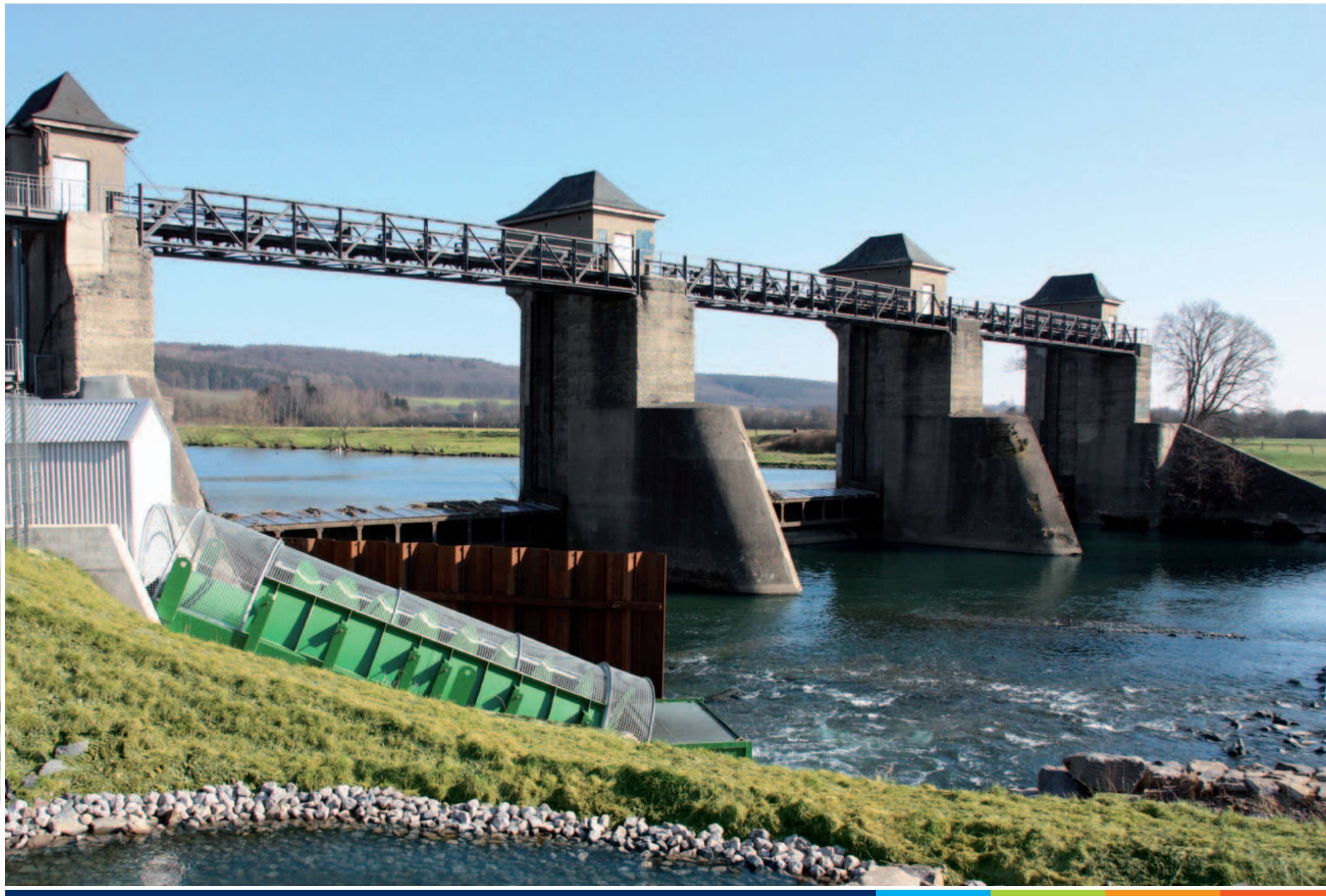
Strömung (Am Stauwehr an der Ruhr bei Wickede erzeugt eine Archimedes-Kraftschnecke Strom. Eine Fischtreppe ermöglicht Wasserlebewesen den Aufstieg.) Fotograf: Klaus Schmedtmann
